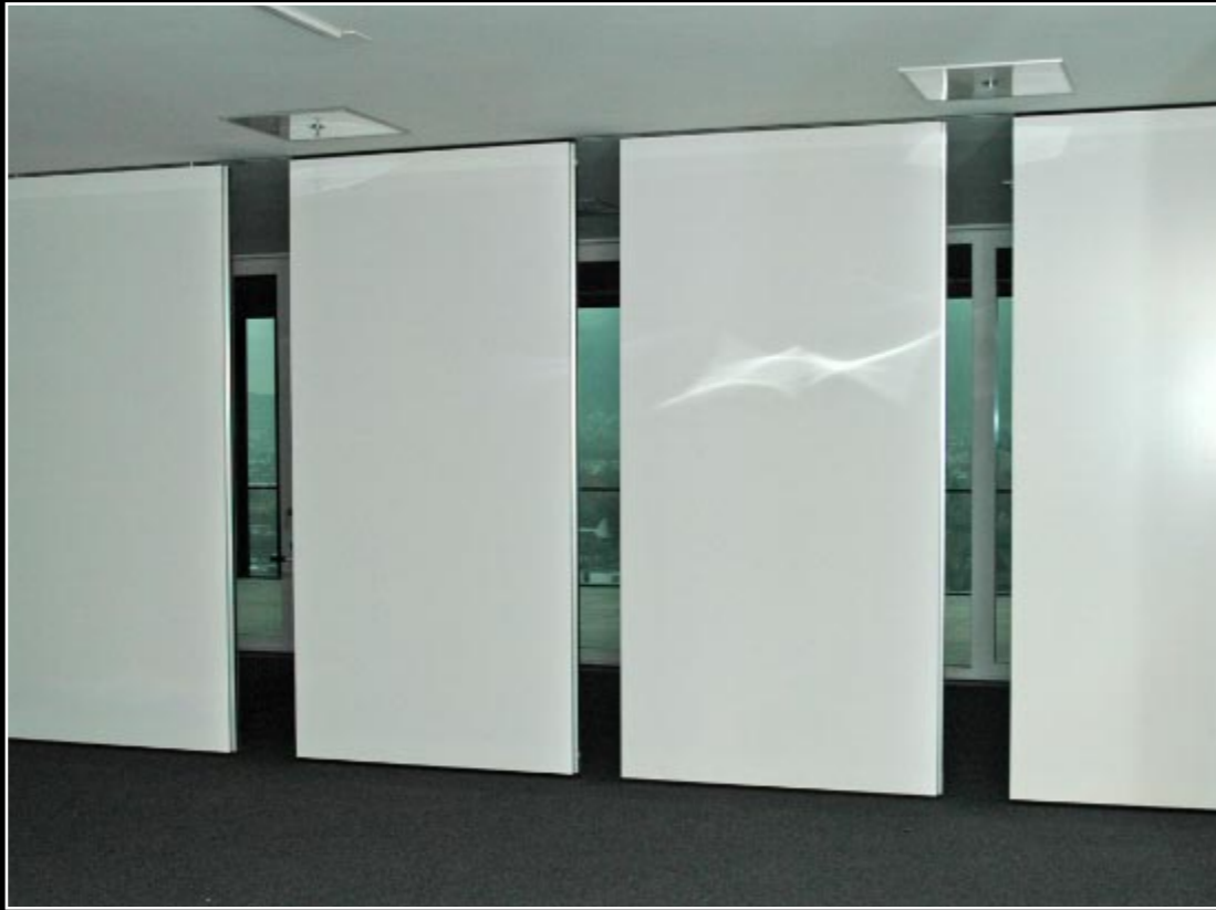
Die mobile Trennwand ist montiert
