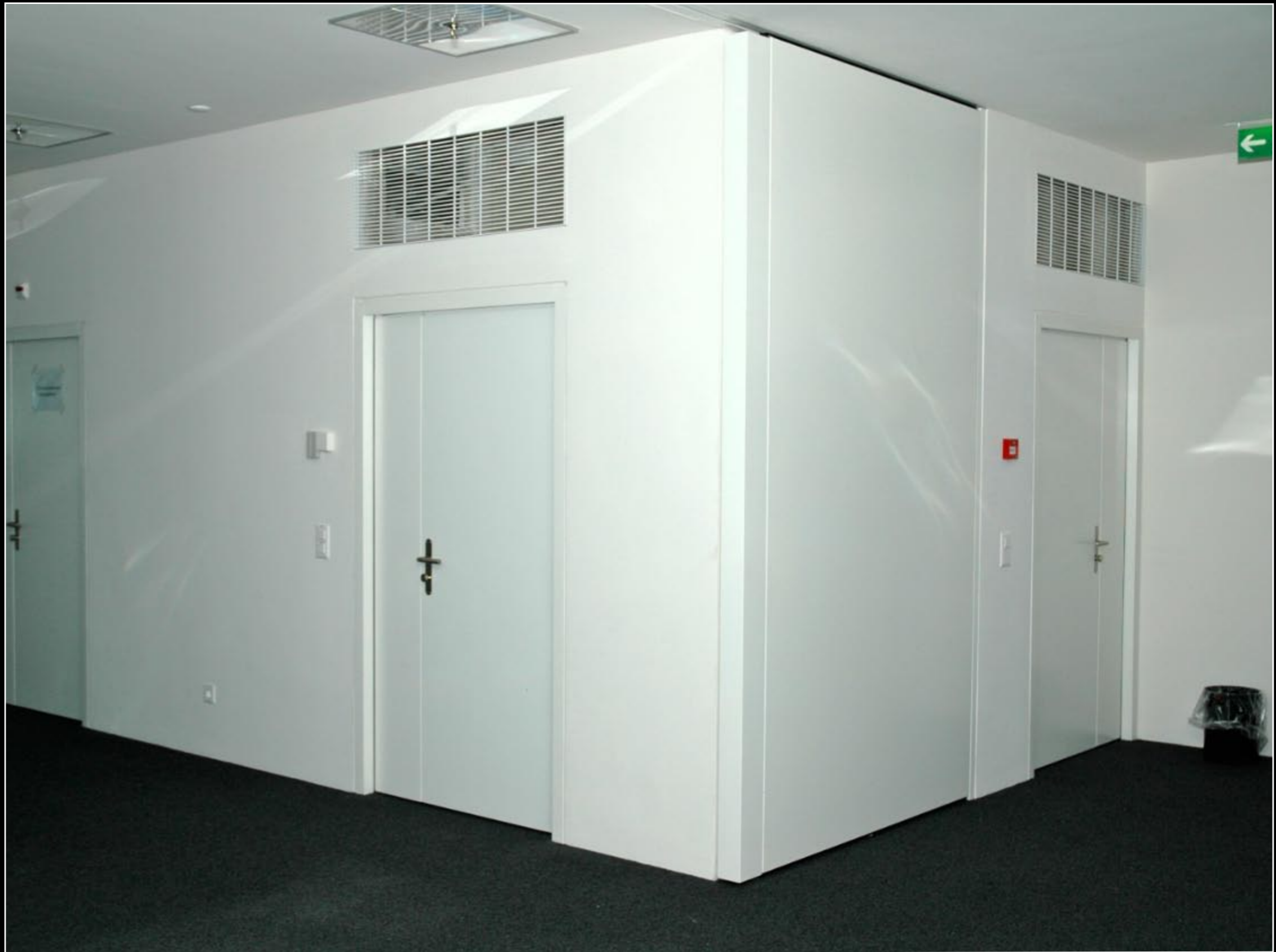
Die mobile Trennwand ist im Bahnhof abgestellt!
